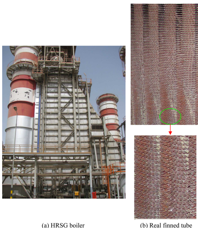
Fig. 1. The HRSG boiler of the fajr petrochemical complex and a real finned tube.
